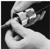
3.- Mezcle el compuesto sellador y compacte los conductores sobre la armadura.
